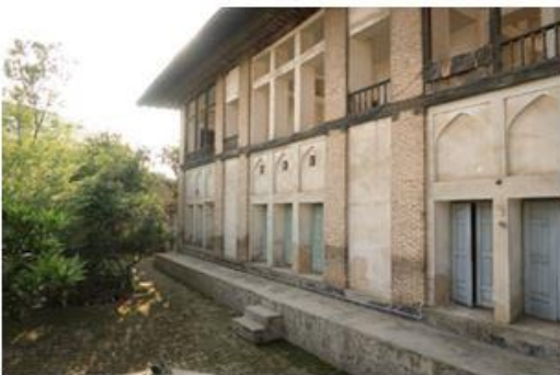
تصویر ۱۰، نمای جبهه شمالی ساختمان اصلی، منبع نگارندگان
