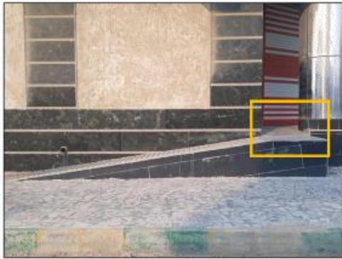
تصویر ۱۱. رمپ نامناسب و غیراستاندارد
