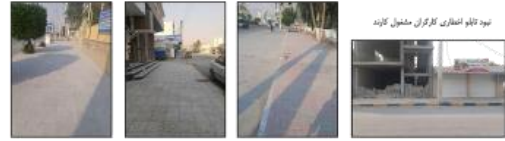
تصویر ۲. نبود علائم هشدار و کف پوش مناسب نابینایان در پیاده‌رو
