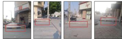
تصویر ۳. اختلاف سطح غیرمجاز پیاده‌رو و خیابان
