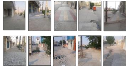
تصویر ۴. کف‌سازی نامناسب و نامتوازن و وجود مصالح متنوع در پیاده‌رو
